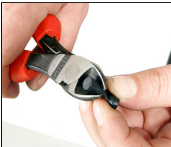
Vräng gummi tätningen och klipp bort mittappen.
