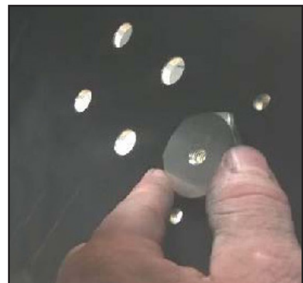
Muttrarna placeras i de förborrade hålen.
